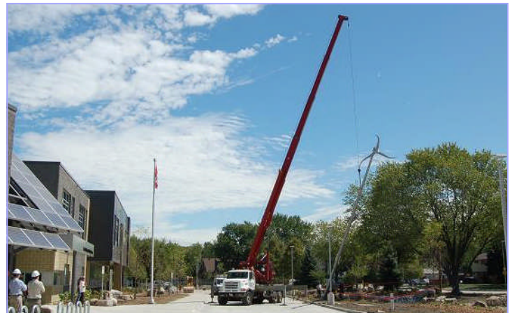
Installation de l'éolienne « Skystream 3.7 » à l'école David Suzuki de Windsor.
